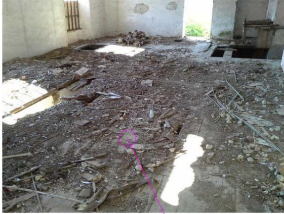
IL PAVIMENTO AL PIANO RIALZATO E' STATO SOLLEVATO PER OTTENERE UNA ALTEZZA MAGGIORE NEL DEPOSITO SOTTOSTANTE.
