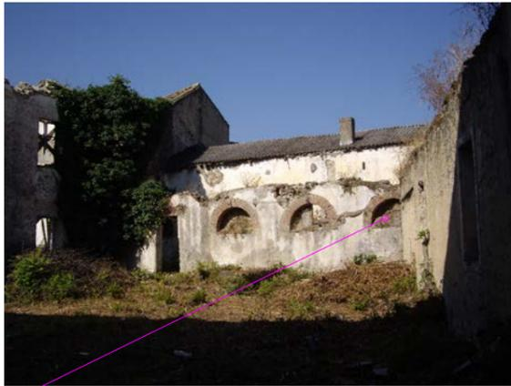
L' ARCO NELLA PARTE DESTRA E' STATO LIBERATO DAL MURO LATERALE MEDIANTE LA REALIZZAZIONE DI UNAVERANDA
